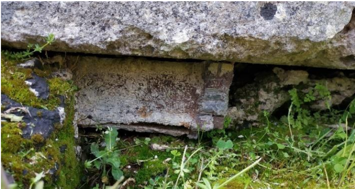
Fig. 7, Particolare "grappa" in ferro rivestita di piombo, dal tempio di c.da Marasà, Parco Archeologico di Locri. Foto: Attilio Varacalli.
